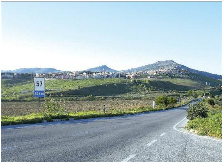
Il tratto della statale a Poggioreale; a destra viadotto ad Altofonte
